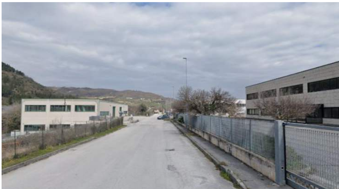
Figura 35 Area industriale presso Serra San Quirico
