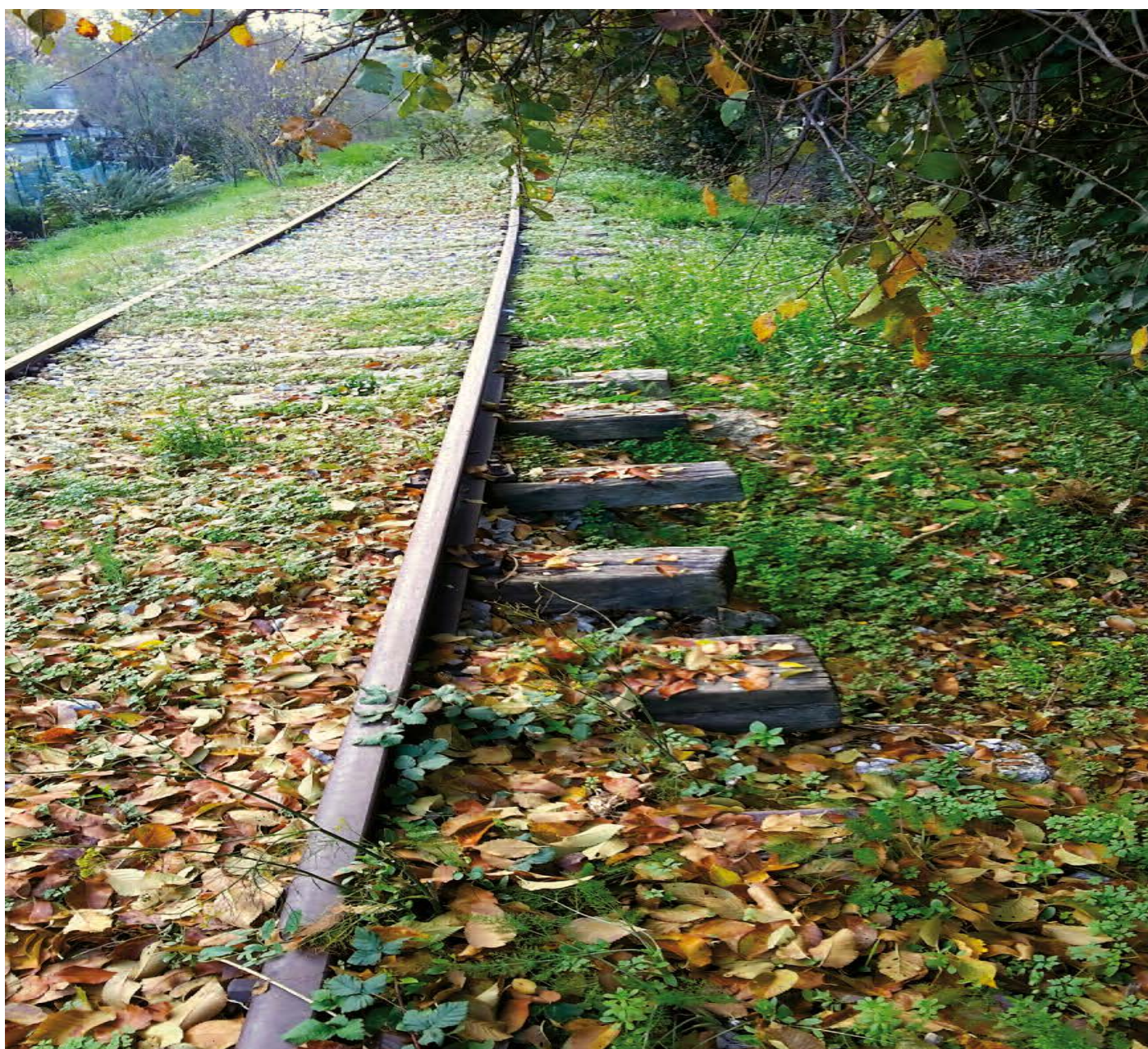
Binari sulla linea Fano-Fermignano-Urbino
