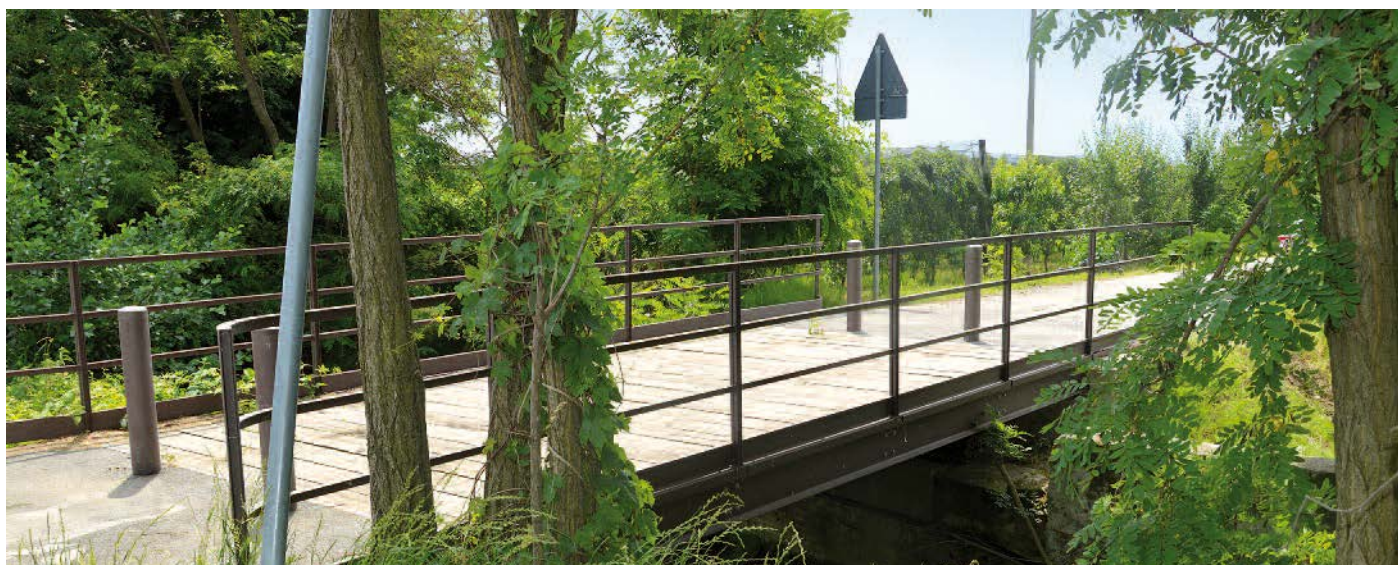
Ponte sulla linea Bricherasio-Barge
